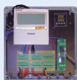
AHU-kit Styrekort, strømtransformator, klemrække
